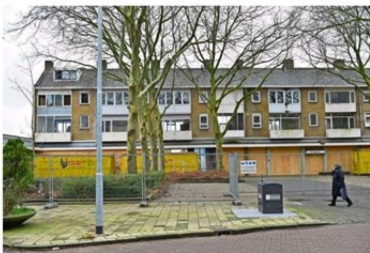
De sloop op de plek van het nieuwe Huis ter Wijk is begonnen.
